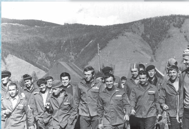
Студенческий строительный отряд. Якутия
